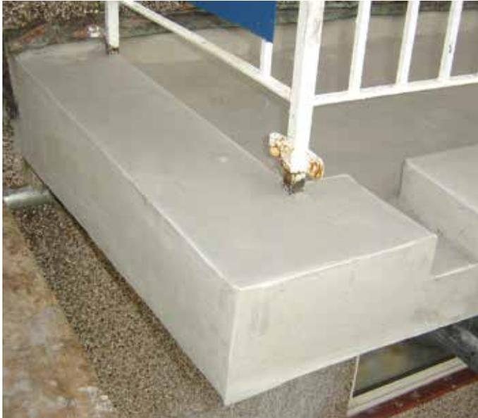
Belzona 4111 (Magma-Quartz) est un composite de réparation multi-usages pour le resurfaçage, la reconstruction et la protection du béton et des ouvrages en pierre.
