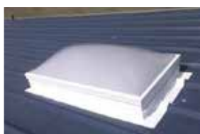
Puits de lumière
