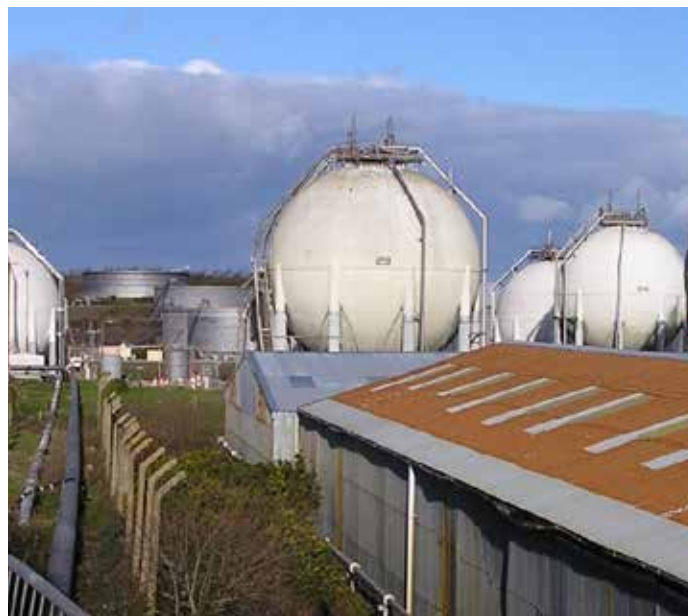
Cuves sphériques de GNL
