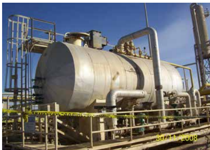
Belzona 5892 utilisé comme revêtement sur un dessaleur
