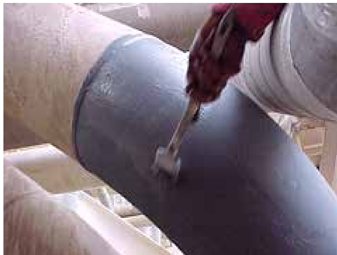
Belzona 5841 utilisé pour protéger les tuyaux contre la corrosion
