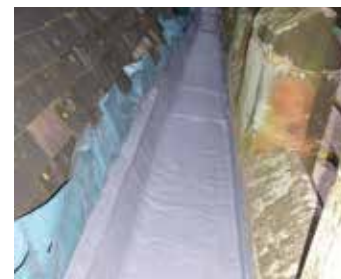
Joints de gouttières
