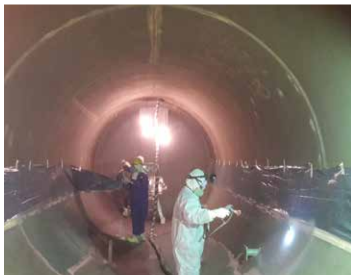
Belzona 1391S appliqué par pulvérisation
