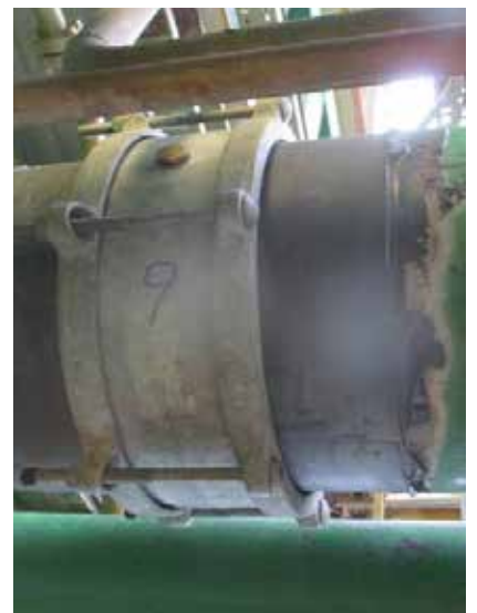
Accouplement réparé et réinstallé
