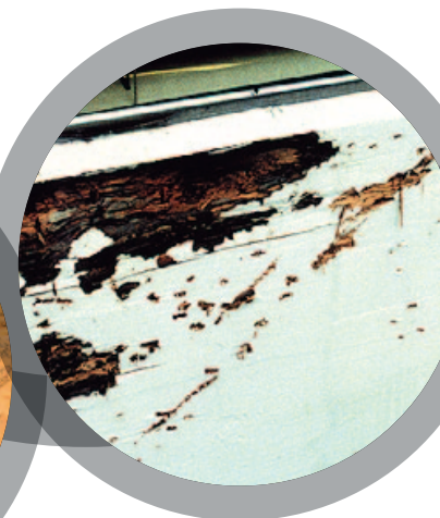
Réparation de bois pourri
