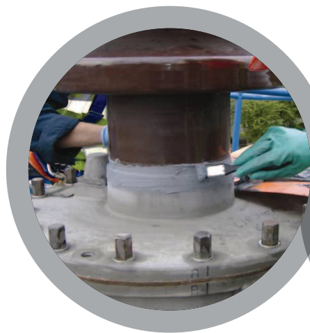
Étanchéité de joints
