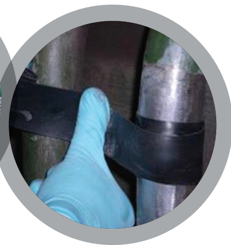
Réparation de fuites d'huile
