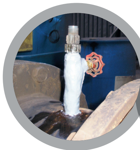
Étanchéité de fuites de canalisations
