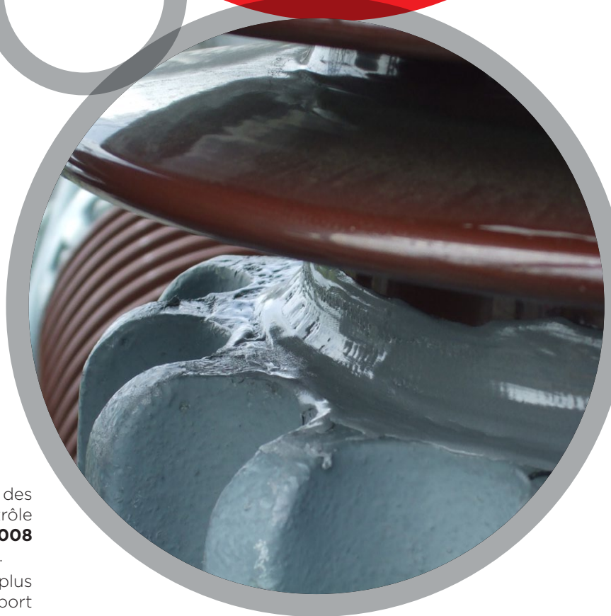
Étanchéité d'isolateur
